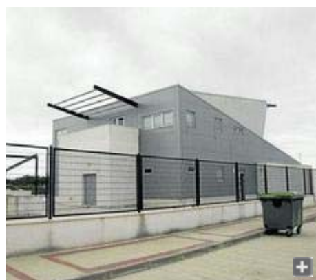
Obras de construcción de la piscifactoría de Futuna Blue en la zona portuaria.
